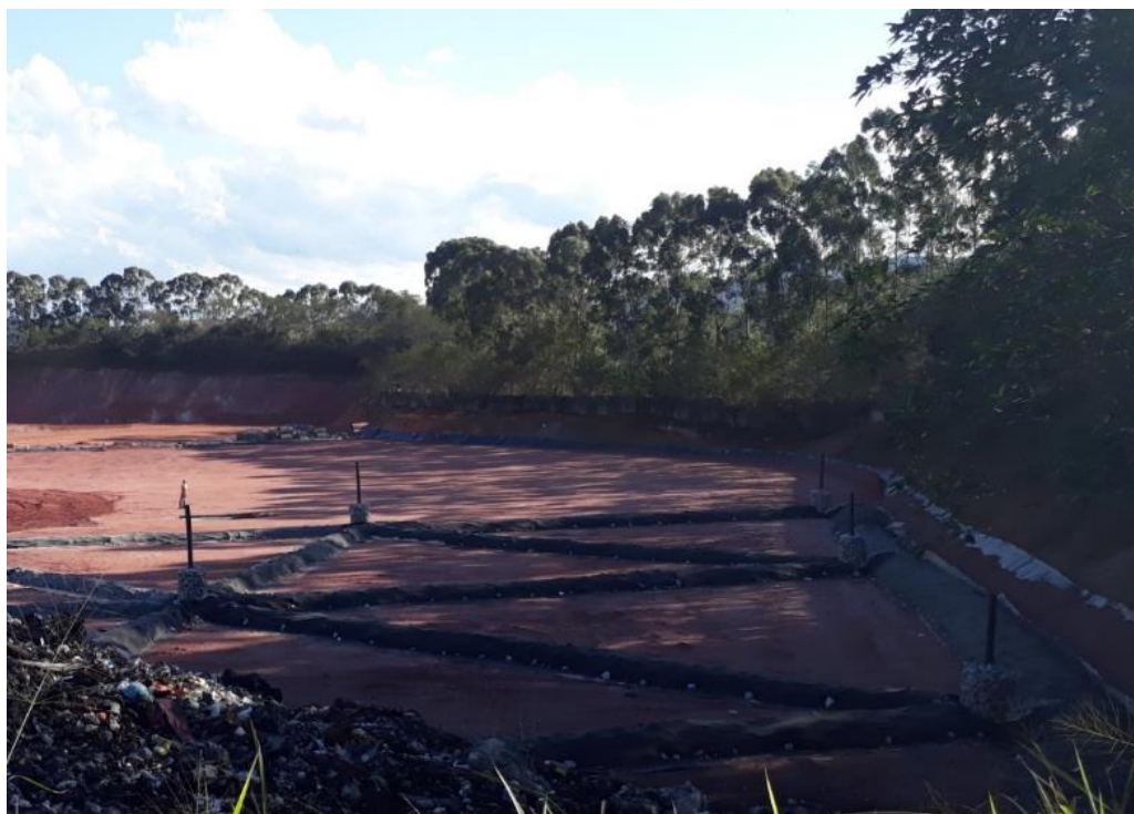
Figura 4 - Rede de drenagem de gás (vertical) e chorume (horizontal) Fonte: Arquivo pessoal, 2018
